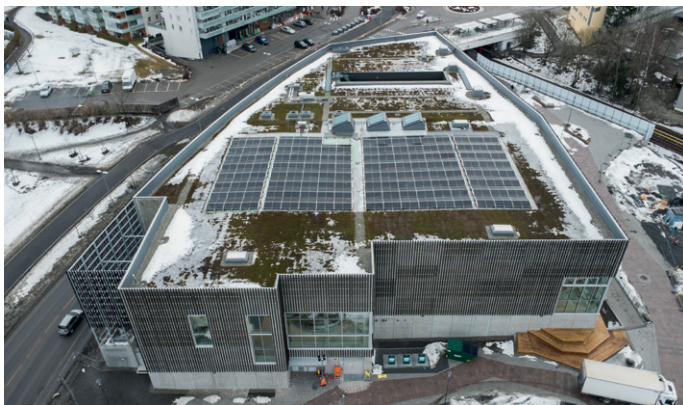
Solcelleanlegget på taket har en maksimal strømprduksjon på 155 kilowatt peak.
